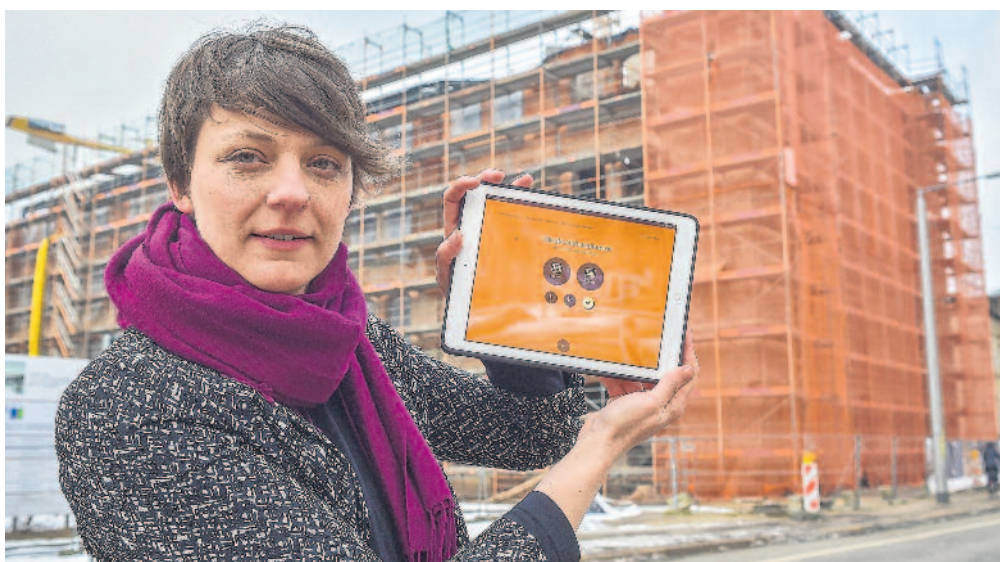
Katja Manz demonstriert die App vor der im Umbau befindlichen Aktienspinnerei. Hier soll sich künftig die Zentralbibliothek der Technischen Universität Chemnitz befinden. Foto: Kristin Schmidt
