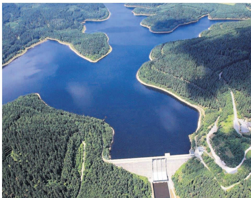
Die Talsperre Eibenstock besitzt im Freistaat Sachsen das größte Fassungsvermögen. 2016 hat der Zweckverband Fernwasser Südsachsen die zehn Jahre dauernde Sanierung einer 32 Kilometer langen Fernwasserleitung abgeschlossen. Sie bringt Wasser aus der Talsperre Eibenstock vom Wasserwerk Burkertsdorf zum Wasserbehälter Steinberg in Chemnitz. In zehn Bauabschnitten trieb man die Sanierung voran. Foto: LTV
