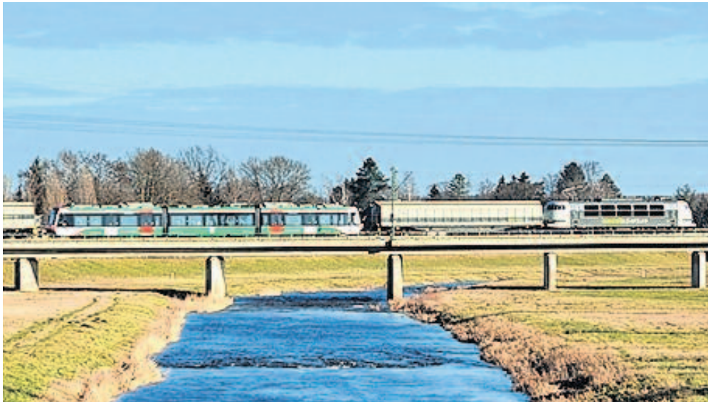
Der neue Citylink bei seiner Überfahrt nach Chemnitz. Bis zum Fahrplanwechsel 2018/2019 werden alle 12 Bahnen im Einsatz sein. Foto: Hans-Jürgen Warg
