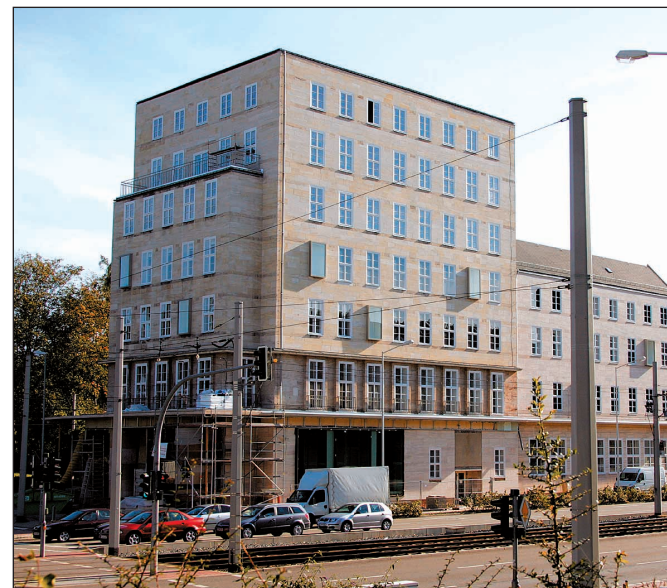
Letzte Fassadenarbeiten am Museum Gunzenhauser.
