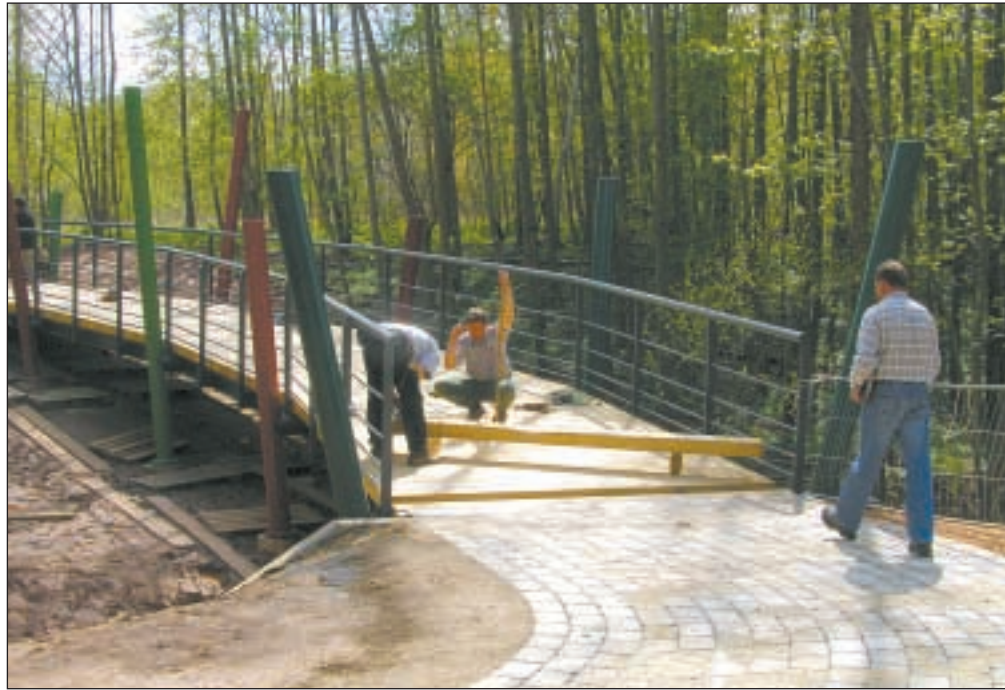
Letzte Arbeiten vor der Eröffnung am Steg.
