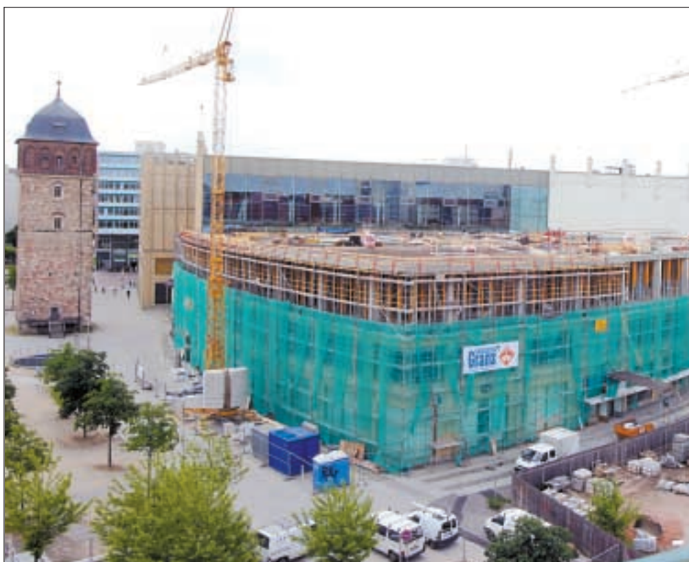
Noch vor dem Weihnachtstrubel soll der Auf- und Umbau beendet sein.
