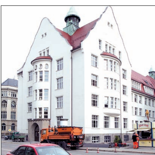
Während der Sanierungen im Rathaus tagt der Stadtrat in der Aula der Handwerkerschule. Rund 30 Besucher können dort die Debatten verfolgen. Foto: Sax
