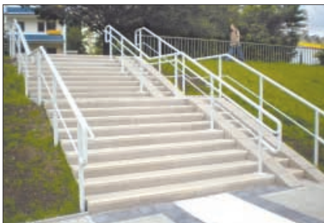
Die neue Treppe mit Rampe erspart Rollstuhlfahrern Umwege.
