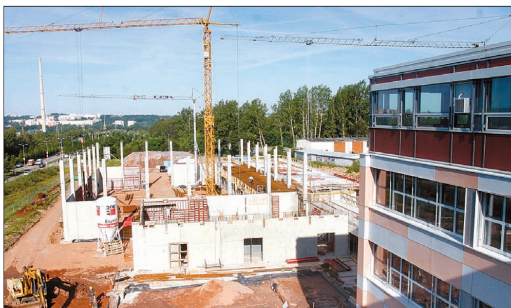
Derzeit in vollem Gange sind die Bauarbeiten auf dem Gelände des Sportgymnasiums.
