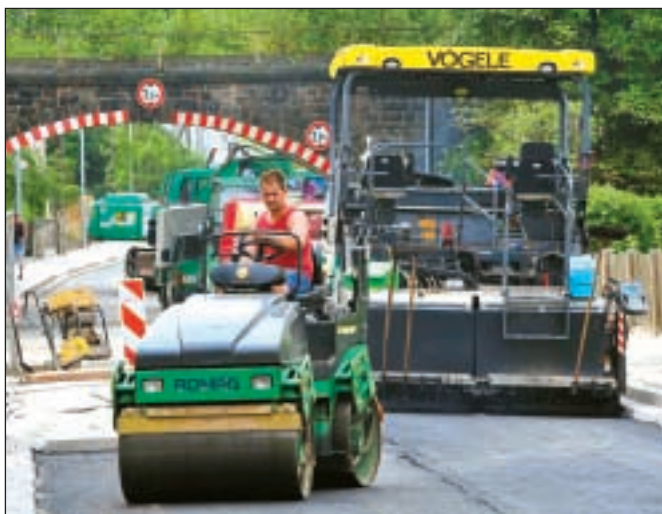
Die letzten Arbeiten sind in der Riedstraße im Gange.
