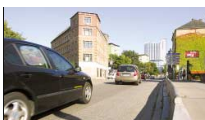
Die Hartmannbrücke soll bis Oktober 2010 erneuert werden. Umleitungen führen unter anderem über die erst jüngst erneuerte Bierbrücke. Foto: Sax
