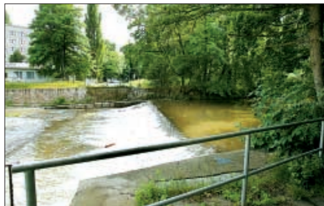
Die Pfeiler der alten Brücke wurden durch die Wassermassen verdrückt und das führte schließlich zum Abriss. Die neue Hängkonstruktion lässt größere Wassermengen ungehindert fließen. Foto:Sax
