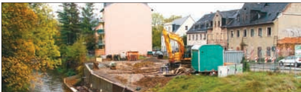
Derzeit wird am Flusssufer an der Hauboldstraße die Ufermauer saniert.
