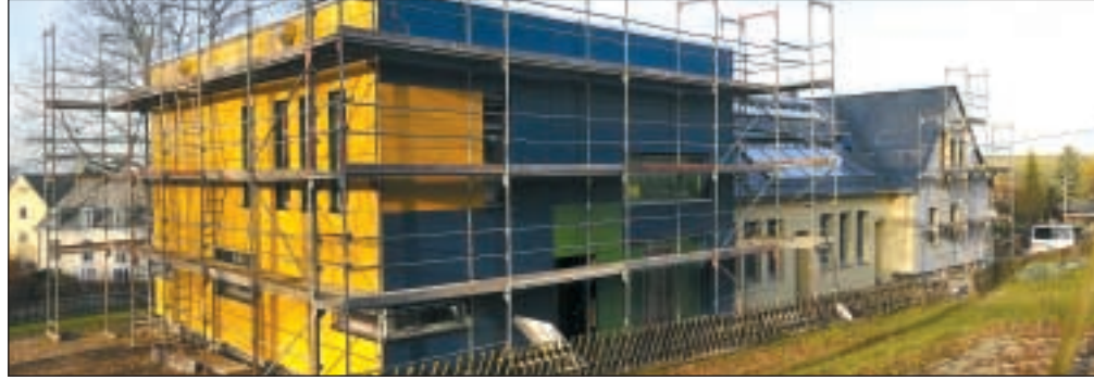
Im Frühjahr können sie wieder in ihre sanierte Kita am Drosselsteig umziehen.
