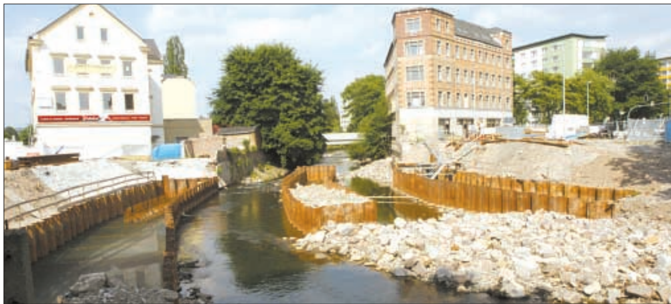
Der Abbruch des Hauses ist ab 19. Juli geplant, in der Folgeweche können die Bauarbeiten an der Brücke weitergehen.
