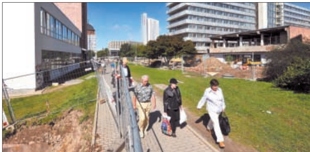
Ein weiterer Abschnitt des Walls wird jetzt in Angriff genommen.
