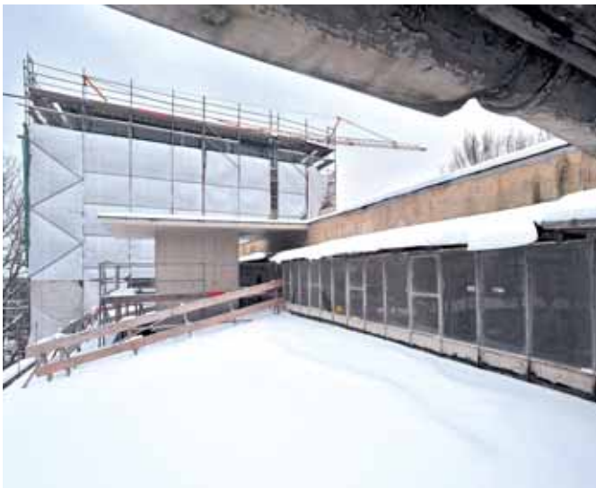
Besucher betreten ihre Zimmer im Obergeschoß über eine Galerie. Diese soll denkmalgerecht rekonstruiert werden. Eine knifflige Aufgabe, denn auch heutige Sicherheitsanforderungen müssen bei diesem Vorhaben erfüllt werden. Foto: Schmidt
