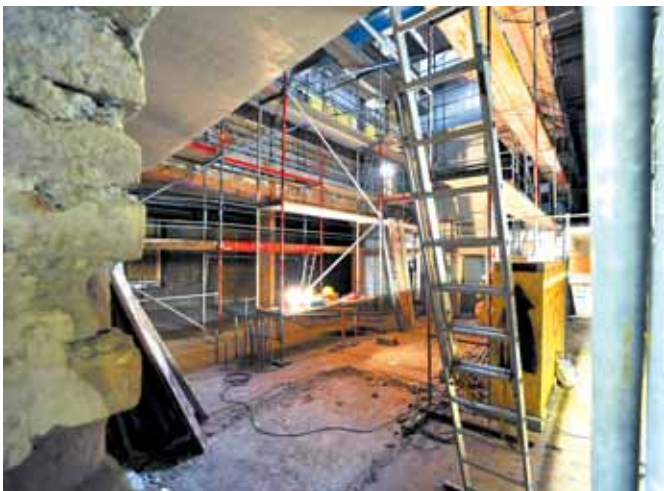
Noch schwer vorstellbar: Die imposante frühere Maschinenhalle des Umspannwerkes wird künftig Eingangsbereich des Hostels. Foto: Schmidt
