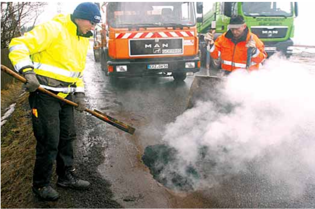
Mitarbeiter eines Tiefbauunternehmens beim Ausbessern von Schlaglöchern auf der Zschopauer Straße zwischen Südring und Adelsbergstraße. Foto: Andreas Truxa
