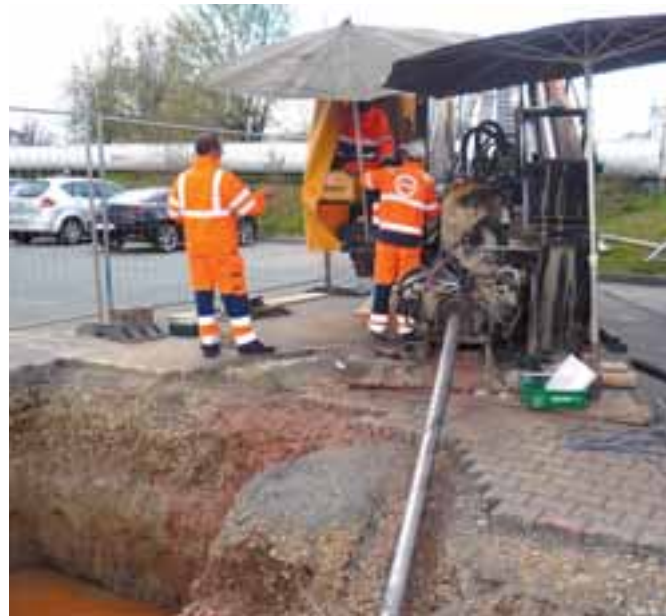
Spezialbohrungen sind nötig, um eine Filtervorrichtung zum Säubern von kontaminiertem Grundwasser auf dem Gelände des früheren Chemiehandels zu installieren. Foto: Beate Wildemann
