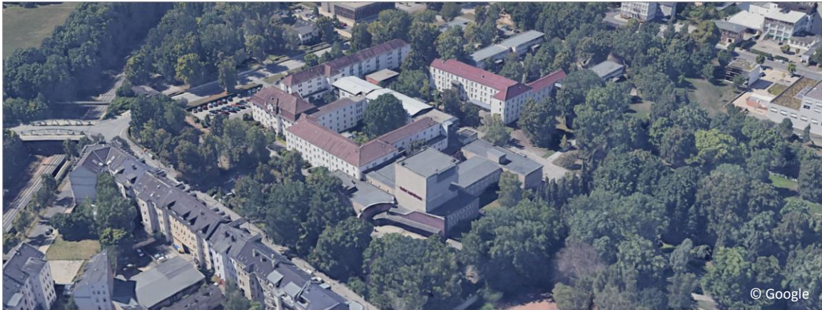
Historisches Schauspielhaus | Blick von Nordosten mit Anschluss Zieschestraße und Park Odf
