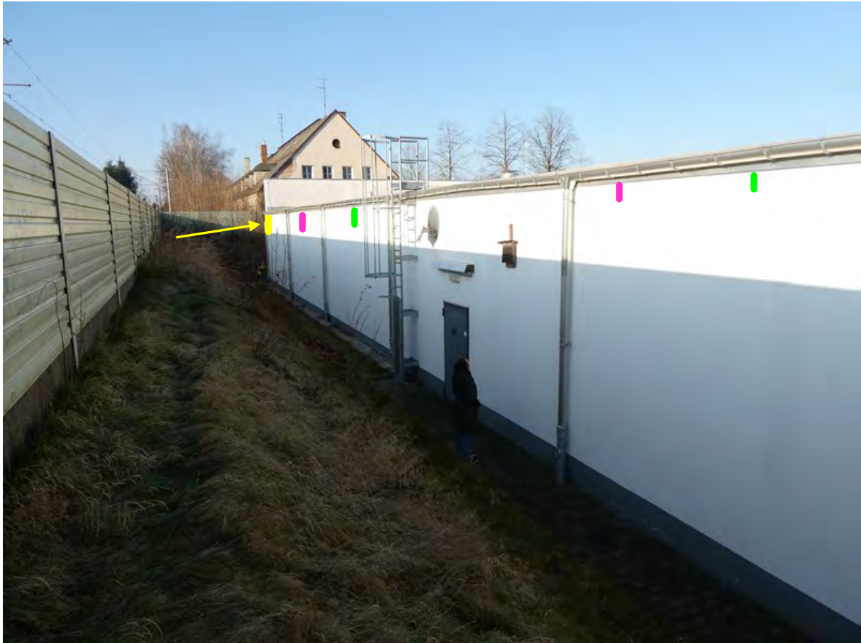
Foto 34: Süd-Fassade des Simmel-Markts mit Vorschlag zur Anbringung von Ersatzquartieren: 1x Fledermaus Ganzjahresquartier FFGJ (gelb), 2x Fledermaus Wandquartier groß FWQ-L (pink), 2x Fledermaus Wandquartier mittelgroß FWQ-M (grün), je nicht maßstabsgerecht, 13.12.2024.
