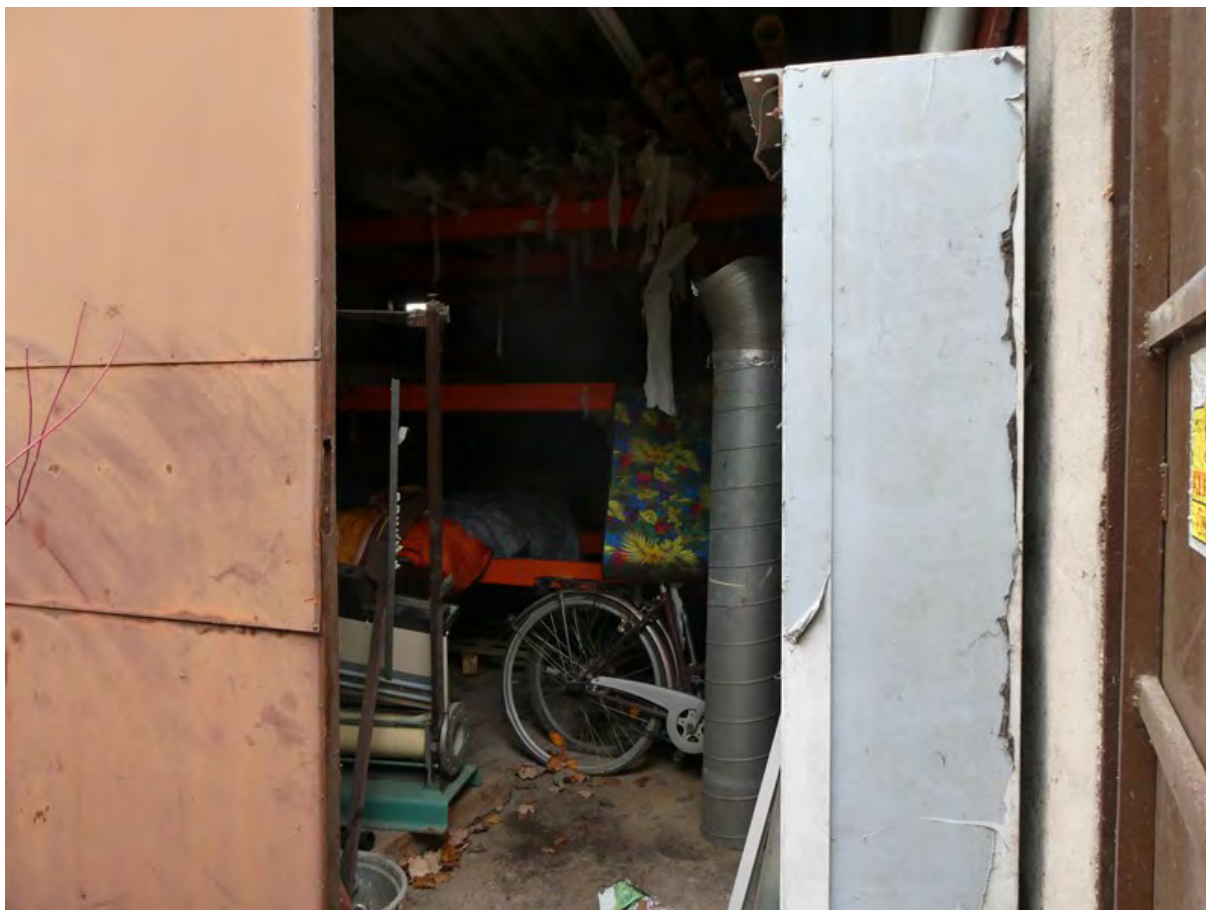
Foto 17: Vermülltes und zugestelltes Abteil des Garagenkomplexes, 02.12.2024.
