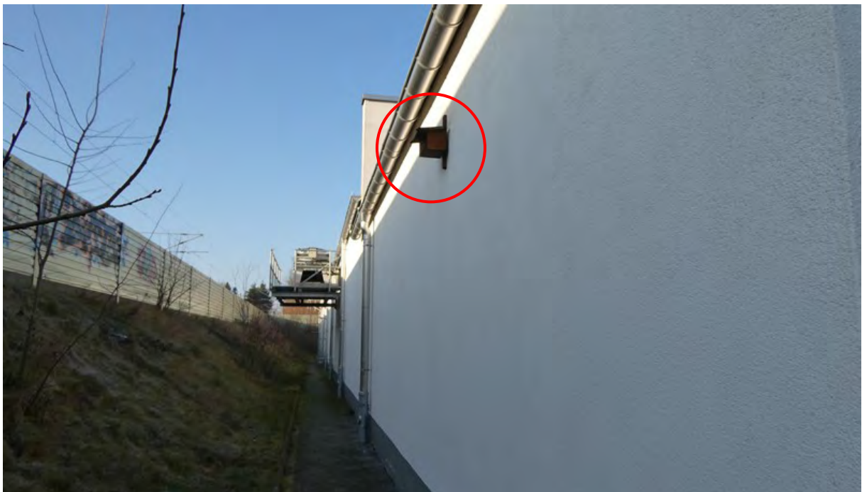
Foto 35: Süd-Fassade des Simmel-Markts, Bestands-Nistkästen (rot) sollen erhalten werden und sind in der Konzeption von Artenschutzmaßnahmen (Kapazität des Lebensraums) berücksichtigt, 13.12.2024.
