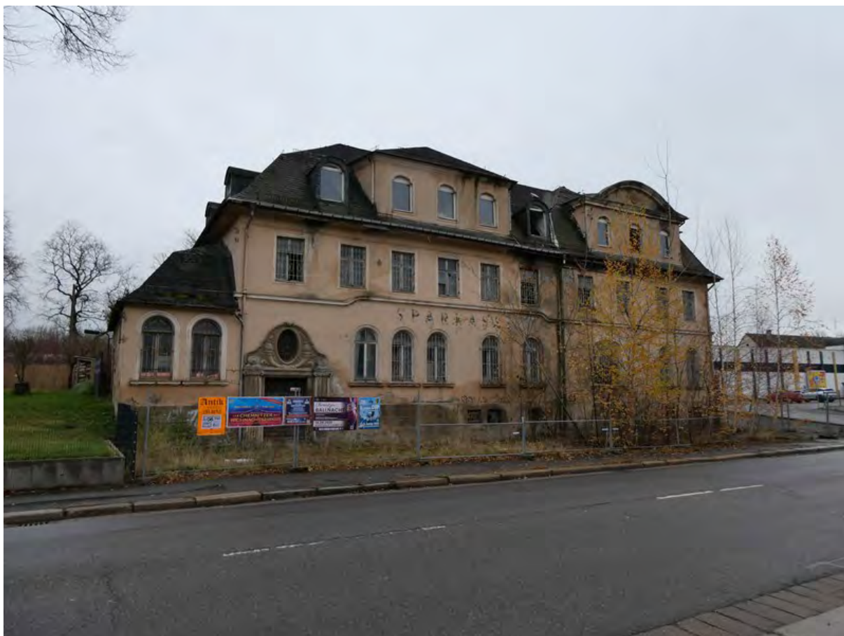
Foto 24: Hauptgebäude Ansicht Zwickauer Straße, 02.12.2024.
