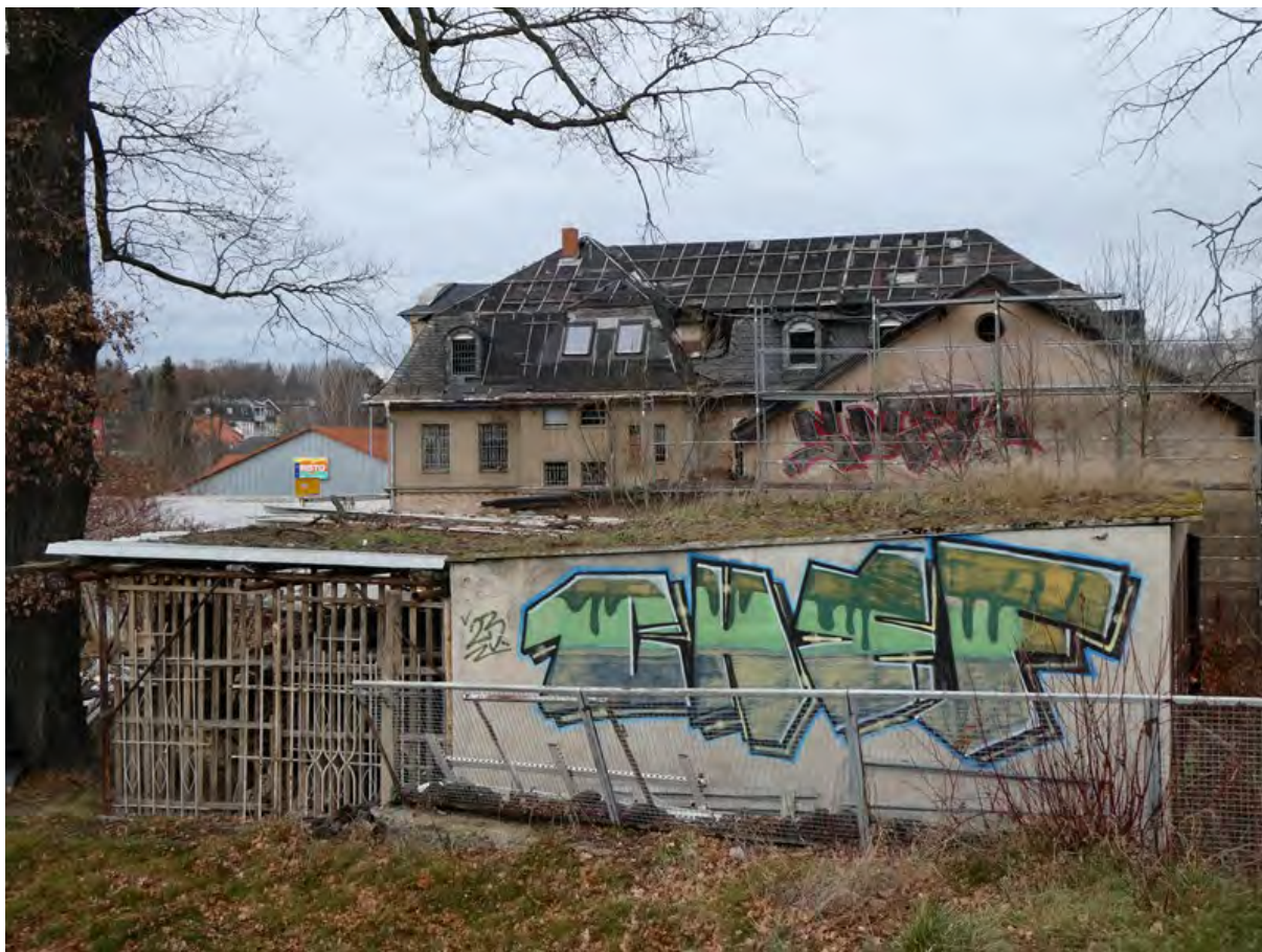
Foto 11: Blick von Süd auf Hauptgebäude mit Garagenkomplex/Anbau, 02.12.2024.
