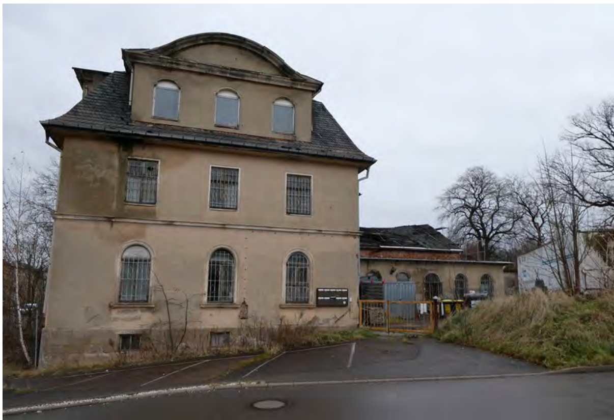
Foto 1: Blick von West auf das Abrissgebäude, 02.12.2024.
