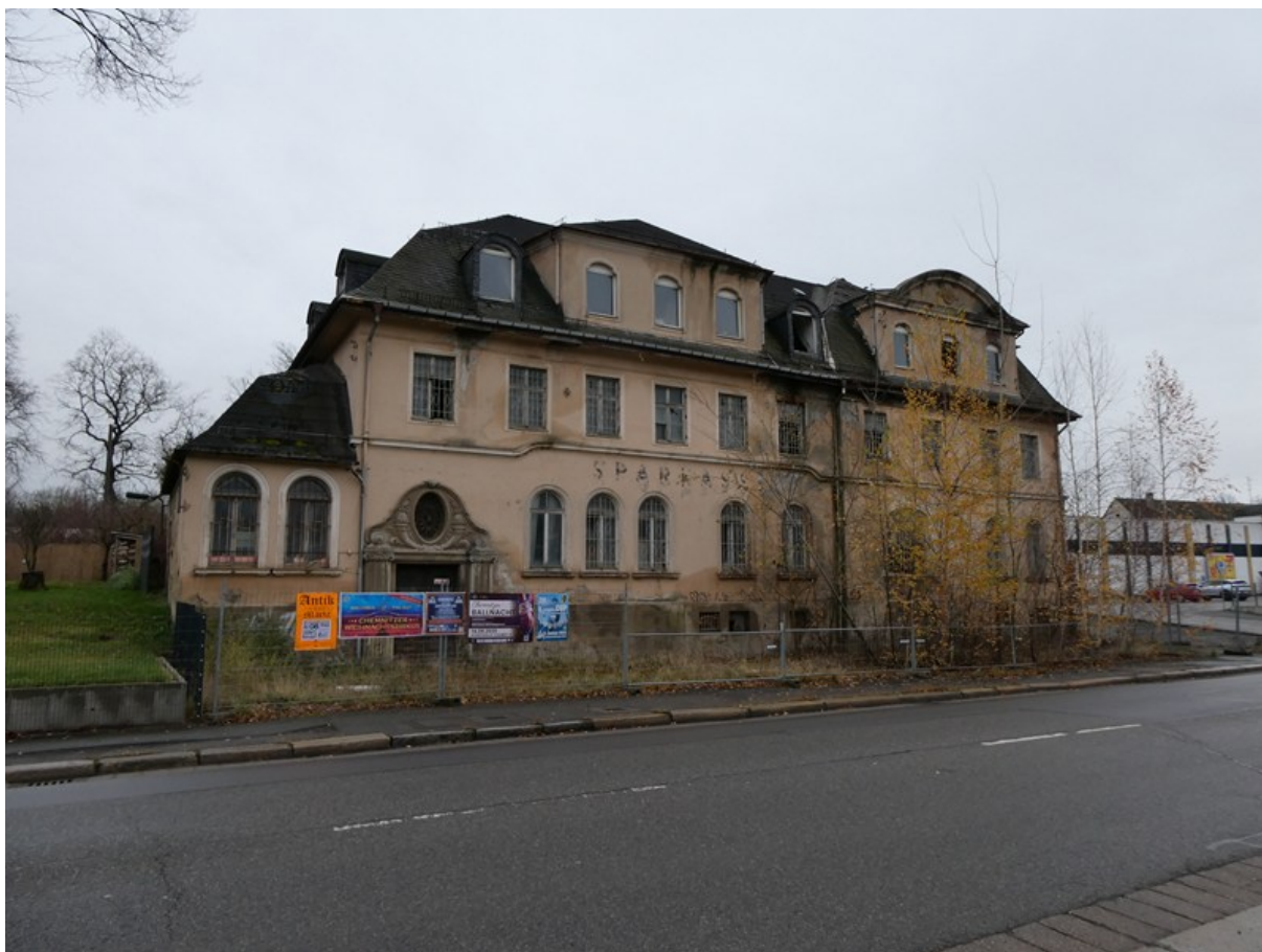
Foto 24: Hauptgebäude Ansicht Zwickauer Straße, 02.12.2024.
