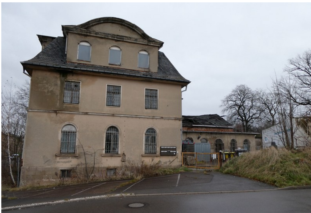
Foto 1: Blick von West auf das Abrissgebäude, 02.12.2024.
