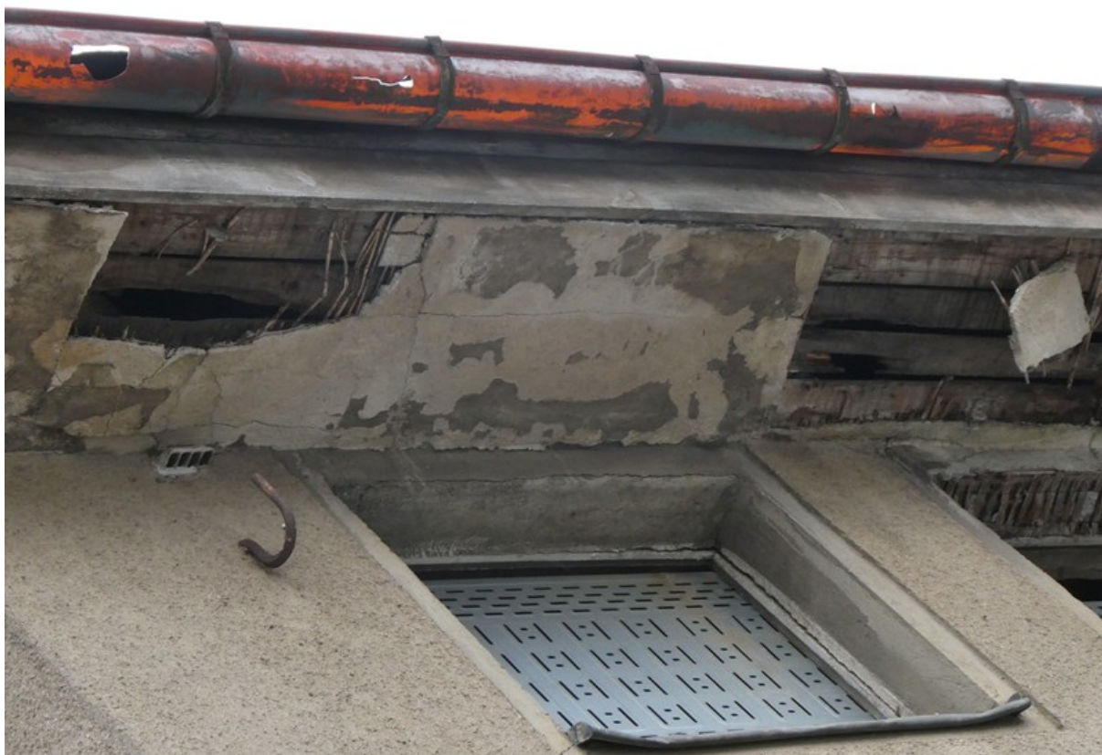
Foto 22: Defekter Dachkasten (exemplarisch) als potenzielles Quartier für Vögel/FIm., 02.12.2024.
