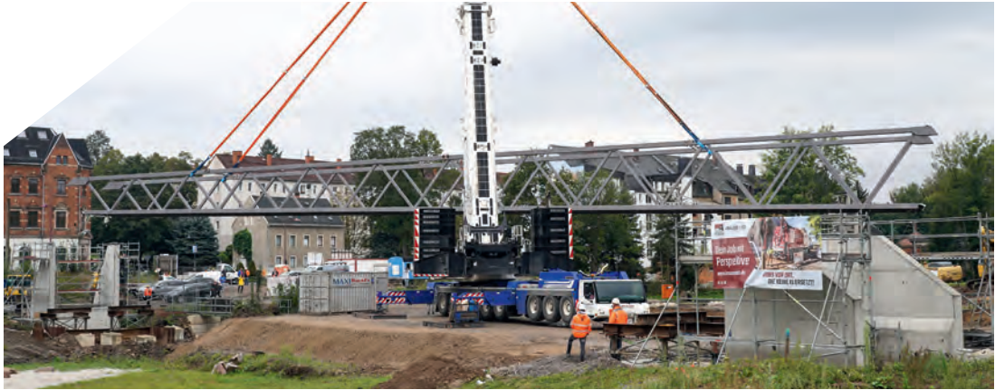
Am 13. September 2024 wurde die Talbrücke im Grünzug Pleißenbach eingehoben.
