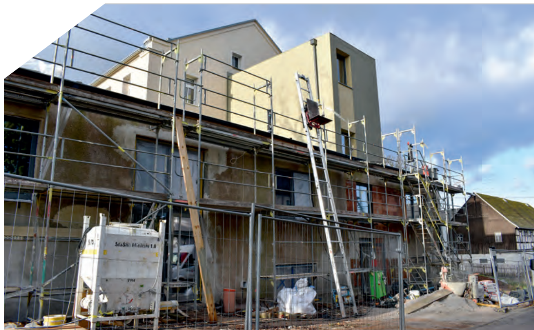
Reges Baugeschehen prägt noch das Bild am Mittelpunkt Mittelbach.
