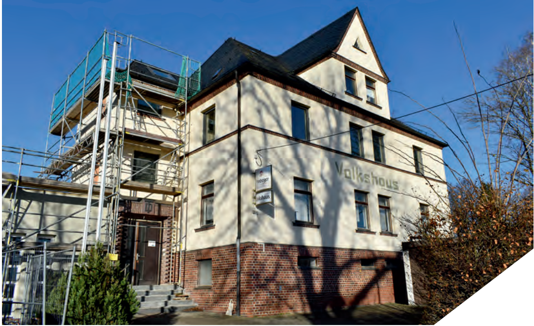
Ende 2024 waren die Bauarbeiten am Vereinszentrum „Arthur Lange“ in den letzten Zügen.
