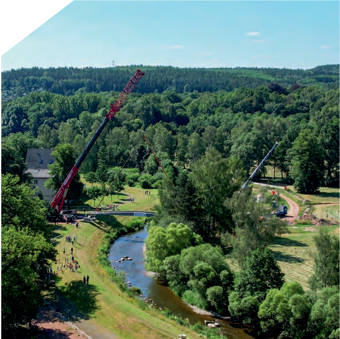
Am 25. Juni 2024 wurden die Segmente der Fußgängerbrücke im ehemaligen Flussbad Altchemnitz mit einem Kran eingehoben.
