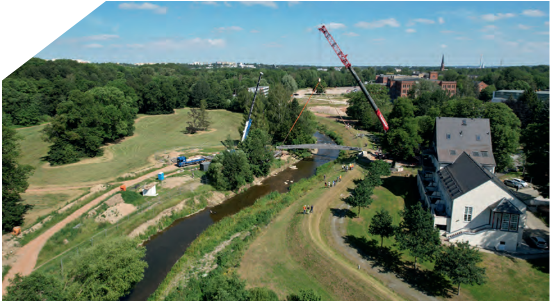
Am 25. Juni 2024 wurde die neue Fußgängerbrücke im ehemaligen Flussbad Altchemnitz eingehoben.
