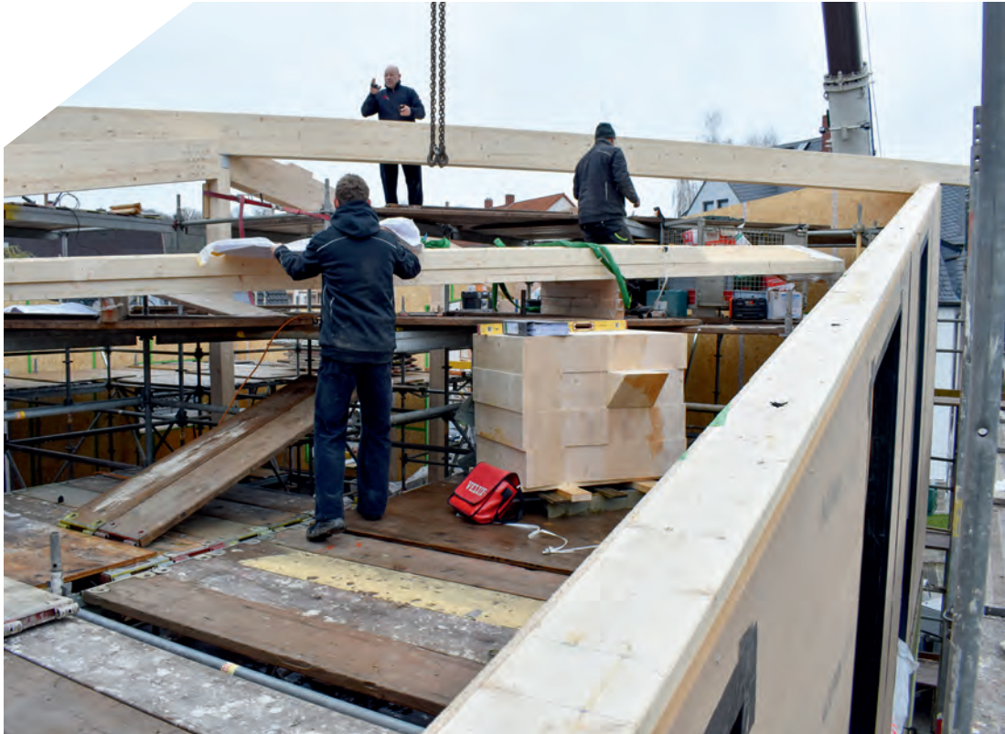
Im November 2024 erhielt der Jugendclub in Einsiedel sein neues Dach.
