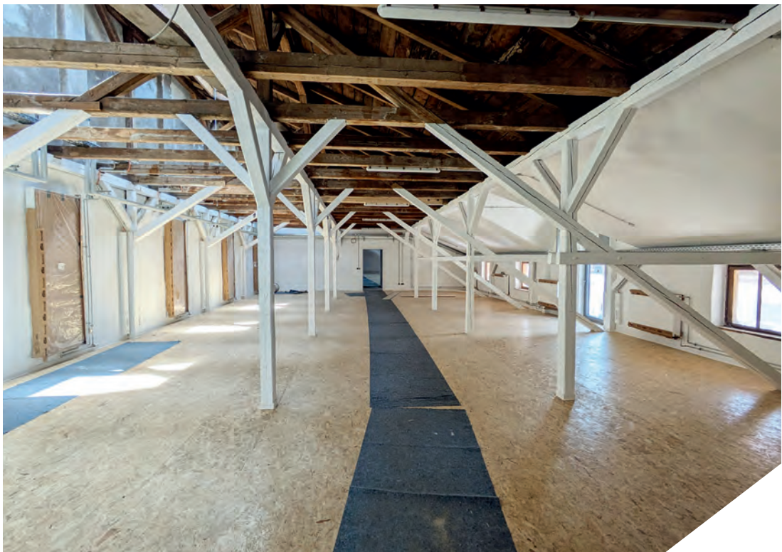
Im Dachgeschoss von Haus A entstehen neue Räume für kreative Ideen.
