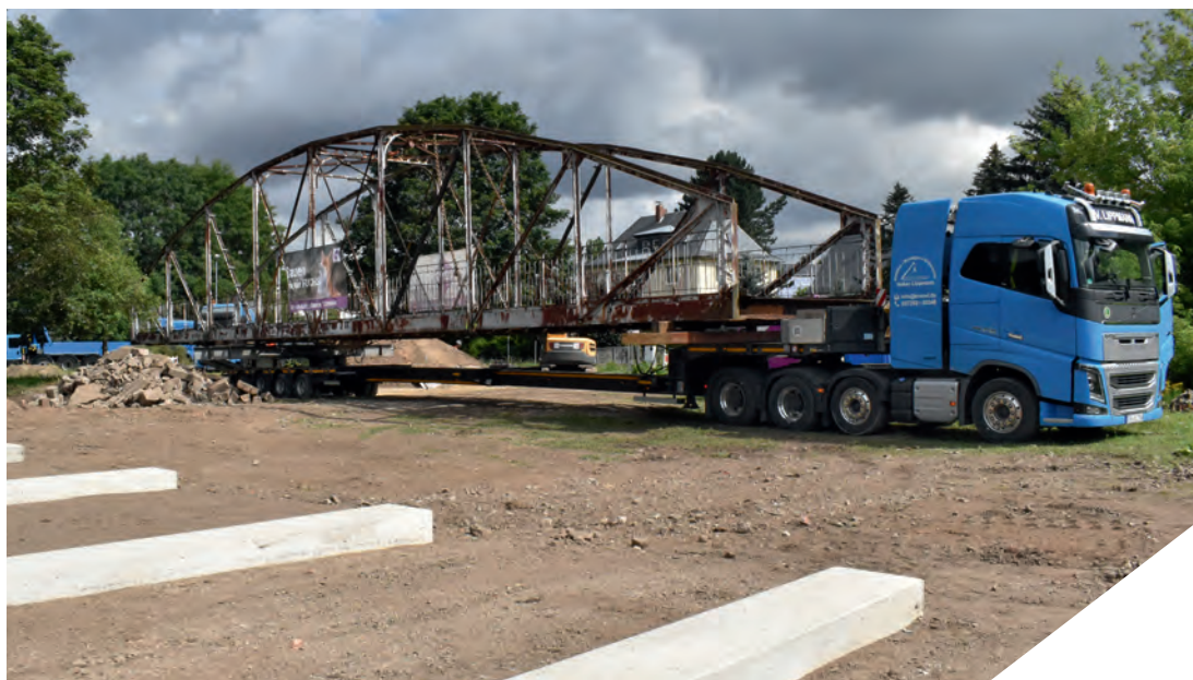
Mitte Juli 2024 wurde die historische Fischwegbrücke an ihren neuen Standort am Rastplatz gesetzt.
