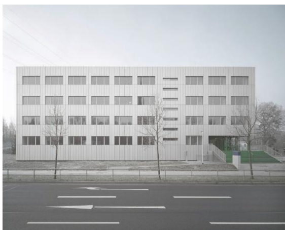
Beispielhafte Sanierung des Polizeireviers Chemnitz-Süd. Bildnachweis: Steffen Michael Gross (heinze.de)
