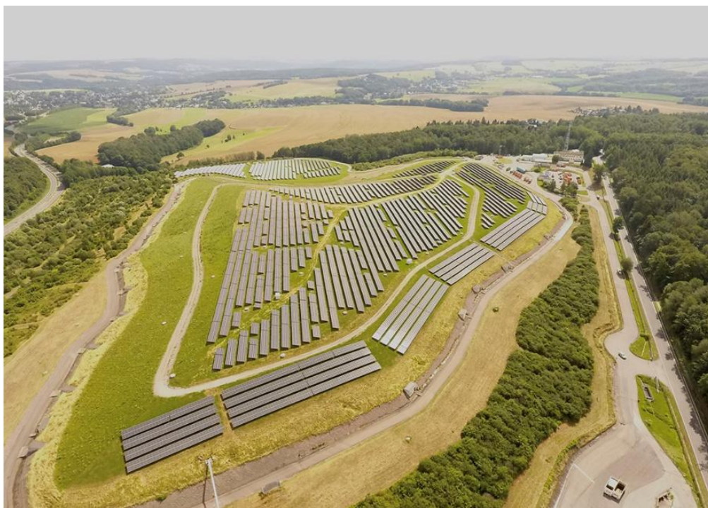
Solarpark Altdeponie Weißer Weg, Bildnachweis: SEAC Group
