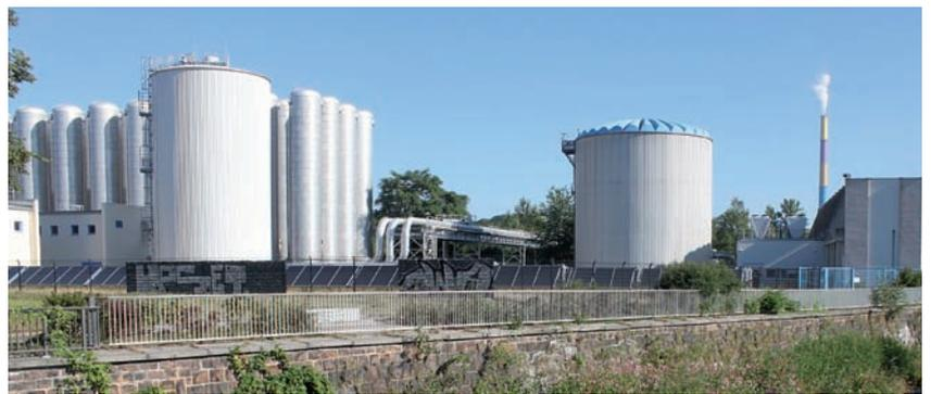
Abb. 42: Solarthermiefeld (li.) und Pufferspeicher (re.)
