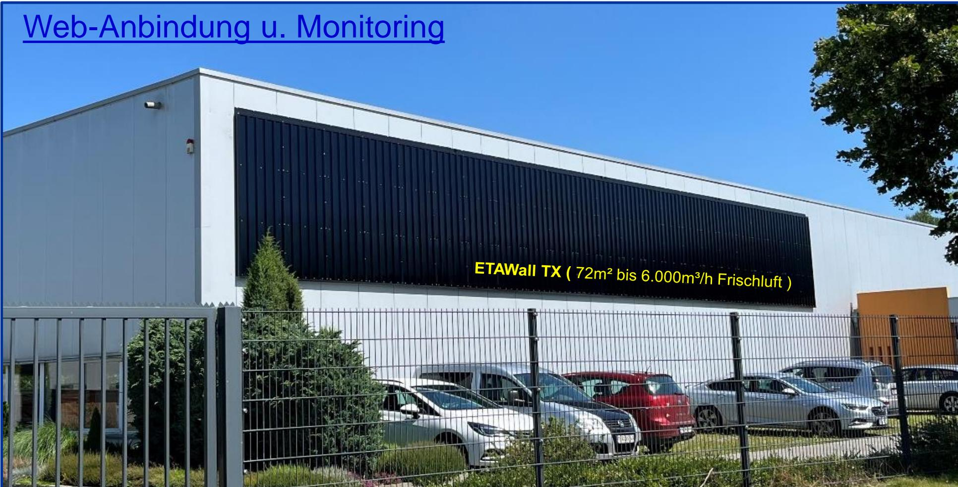
ETAWall TX ( 72m<sup>2</sup> bis 6.000m<sup>3</sup>/h Frischluft )
