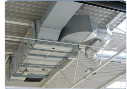
Die **ETAhybrid Strahlungsheizungs-Frischlufthanlagen mit adaptiver Wärmerückgewinnung** nutzen die inneren Wärmelasten einer Halle, von Ihren CNC-Maschinen, technolog. Anlagen,... effektiv aus. Sie bringen damit sauerstoffreiche Außenluft im Winter vorgewärmt unten Zugluftfrei in Ihre Arbeitsbereiche.
