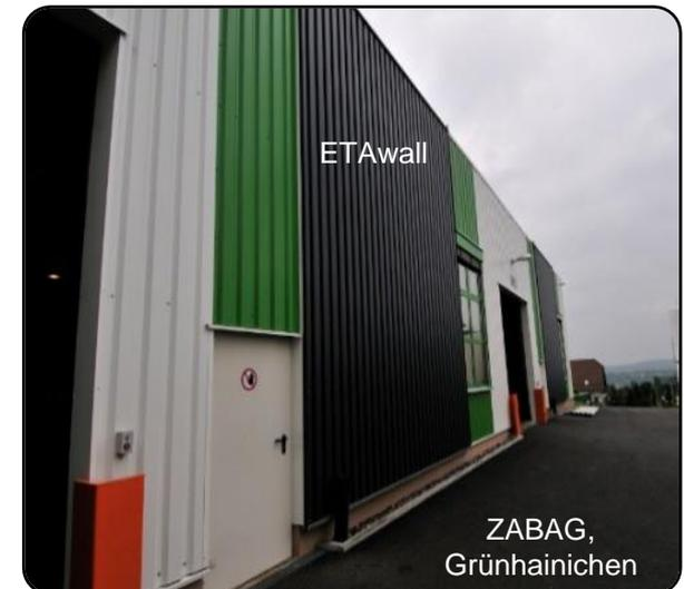
Hocheffiziente **ETAWall TX Solar-Luftkollektoren** für Ihre Halle, neben z.B. dezentralen Grundheizungen mit **energiesparenden Rezirkulations- od. Dunkelstrahlern** (*Heizen wie die Sonne!*), an der Südseite zu installieren, direkt auf die Hallenwand oder auf das Dach (*Direktausnutzung der Wärmestrahlung!*).
