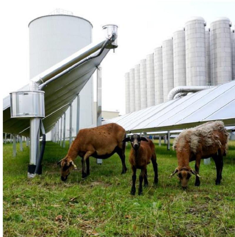
Abb. 1: Großsolarthermie-Anlage der eins, Brühl
