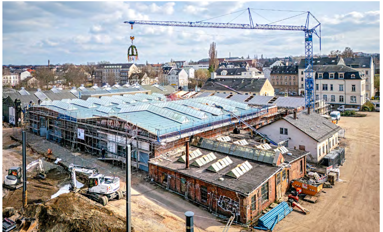
Der ehemalige Straßenbahnbetriebshof wird zum Garagen-Campus umgebaut.
