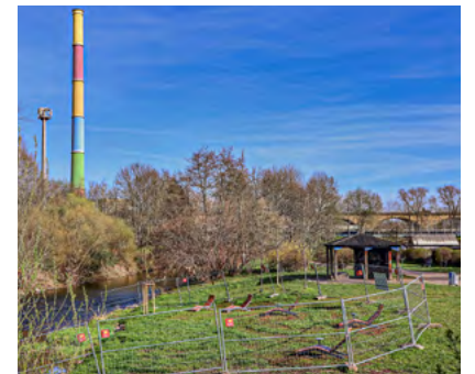
Im Nordpark an der Chemnitz wird der Pavillon saniert. Foto: Franziska Wöllner
