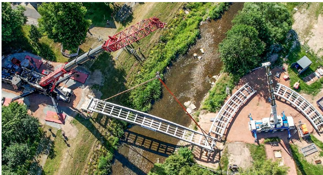
Es benötigt Millimeterarbeit beim Einhub der Brückenelemente, damit die neue Fußgängerbrücke im Flussbad Alchemnitz vollständig verbunden ist. Foto: Philipp Köhler
