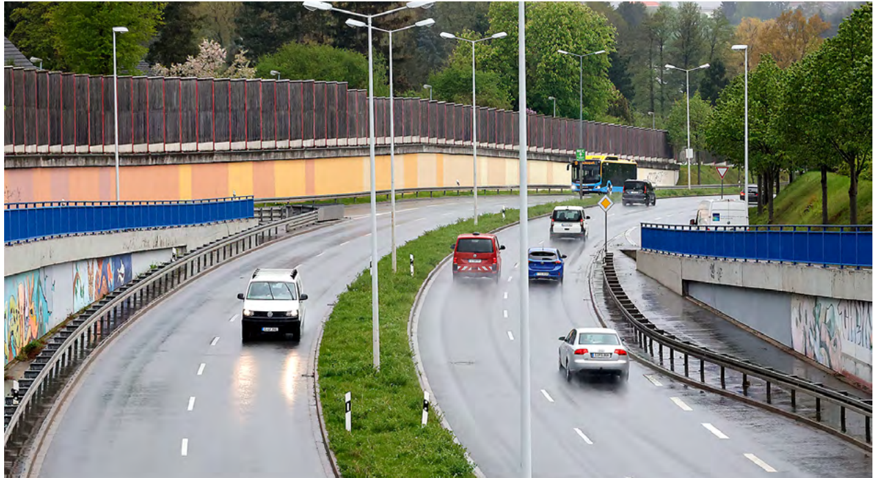
Auf dem Südring werden die Fahrbahnen erneuert.
