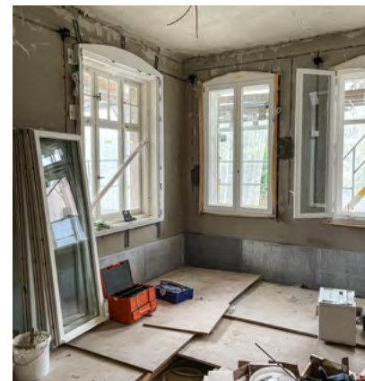
Die Fenster in den Hauptgeschossen werden denkmalgerecht erneuert, auf einen energetisch aktuellen Stand gebracht und den sicherheitstechnischen Ansprüchen angepasst. Foto: Franziska Wöllner
