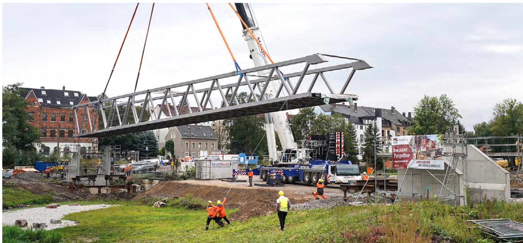
In einem präzisen Manöver wurde die Brücke eingehoben und sicher in den vorbereiteten Widerlagern platziert.
